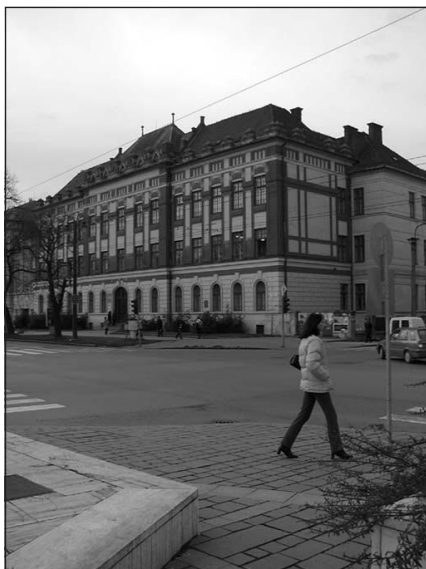
Budova evanjelického kolegiálneho gymnázia
