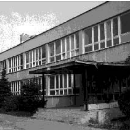
Budova gymnázia sv. Mikuláša
